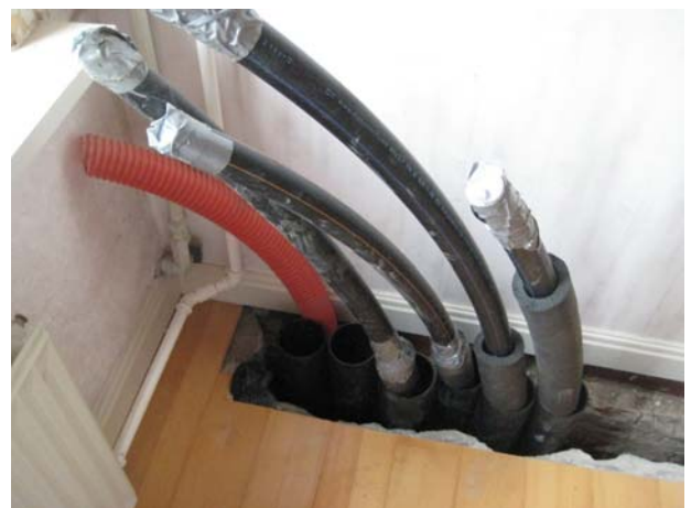
Figur 3.7 Det kan være nødvendigt at håndgrave forbindelsen fra jordvarmeboring til hus for at få installationen af brinerør på plads. På foto til højre ses hvorledes de isolerede rør kommer op i det rum, hvor varmepumpen skal placeres. Foto fra testlokaltet Glud Kirkevej 48.
