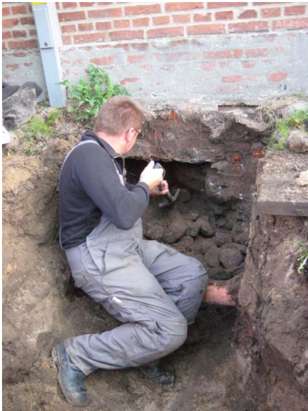
Figur 3.7 Det kan være nødvendigt at håndgrave forbindelsen fra jordvarmeboring til hus for at få installationen af brinerør på plads. På foto til højre ses hvorledes de isolerede rør kommer op i det rum, hvor varmepumpen skal placeres. Foto fra testlokaltet Glud Kirkevej 48.
