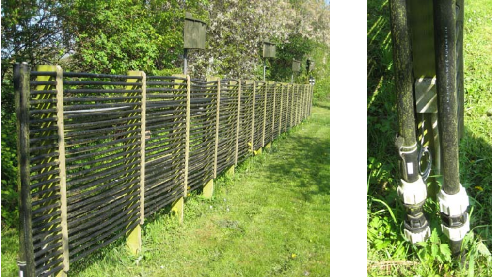
Figur 2.3. Energiabsorber i form af et hegn af sorte slanger. Foto til højre viser temperatursensoren ved basis, der styrer hvornår frostvæsken i slangerne skal cirkulere.
